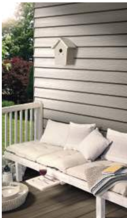
Aplicación Solapado Cedral Texturado
