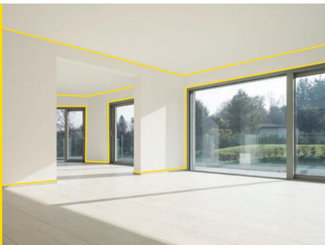
Es imprescindible que en toda solución constructiva de Placas para interiores Durlock® se utilice el sellador acrílico Promaseal-A para garantizar su estanqueidad, resistencia al fuego y mejora acústica del Sistema
