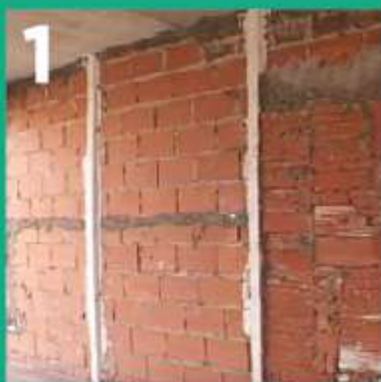
1 Pared interior con fajas.
