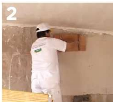
Aplicación con talocha de madera.
