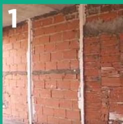
1 Pared interior con fajas.
