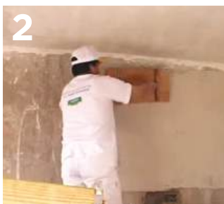
2 Aplicación con talocha de madera.
